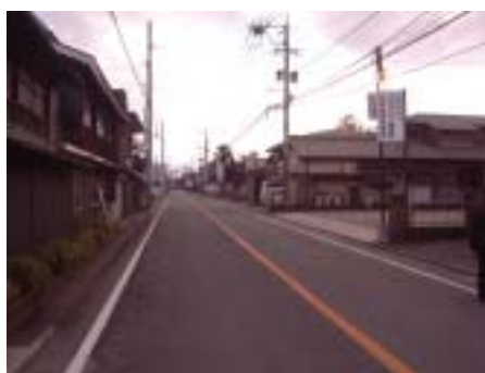
路肩に立つ電柱
