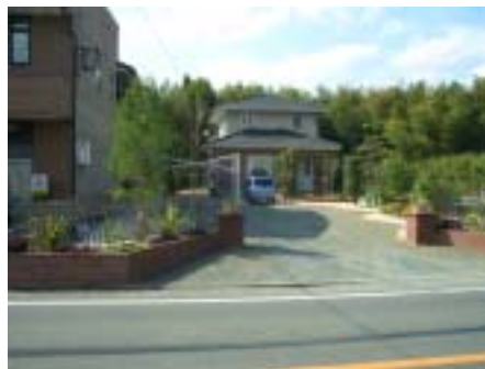
敷地の奥に立つ新しい建物
